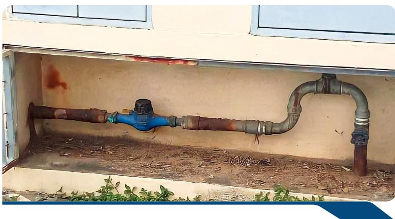
Por décadas se fez o uso de cavaletes hidráulicos em aço galvanizado em obras comerciais, prediais e residenciais. Estudos mostraram que com o passar dos anos, o aço galvanizado sofre com a corrosão química, tornando-o impróprio para a condução de água da rede hidráulica. Este tipo de tubo pode sofrer com a corrosão e enferrujar, prejudicando sua performance e requerendo manutenção frequente.
